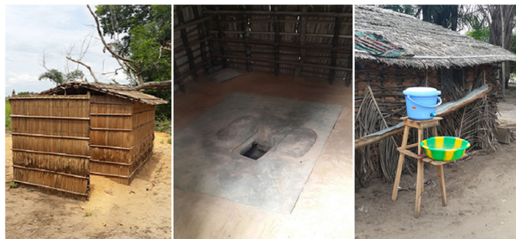
Fig. 5 a A well-equipped latrine, b A well-equipped latrine, c A well-equipped latrine
